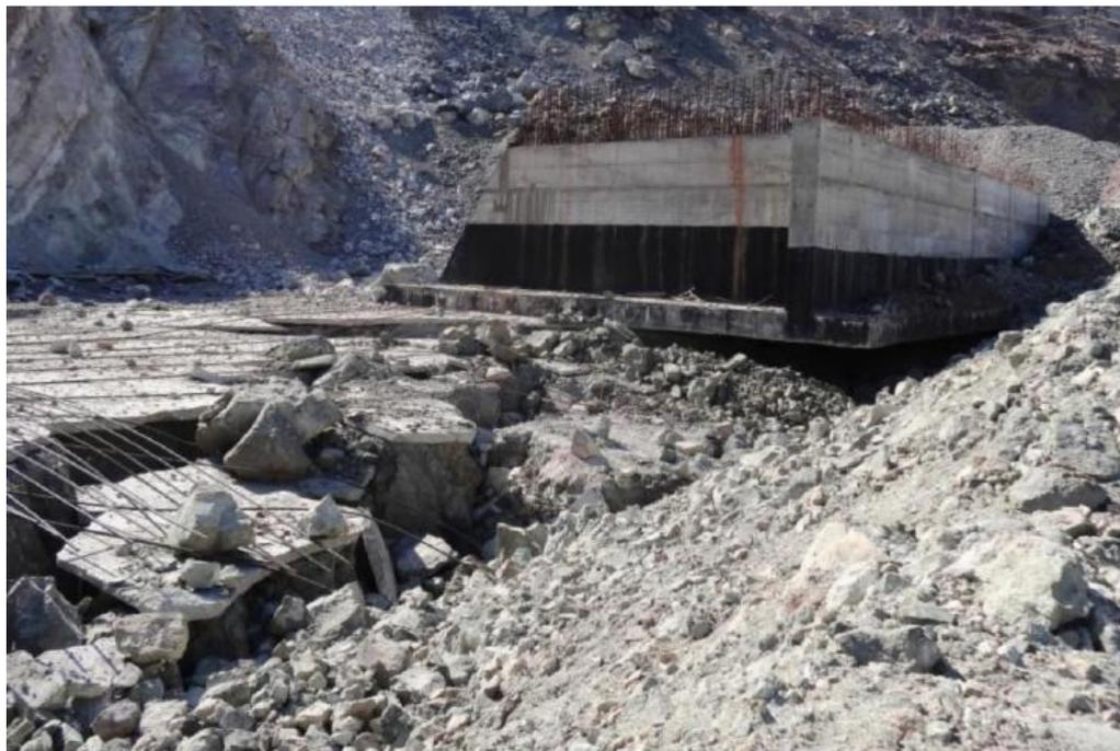
Рисунок 1.1 - Обрушение юго-западного борта Качарского карьера под строившейся подпорной стенкой на горизонте минус 30 м
